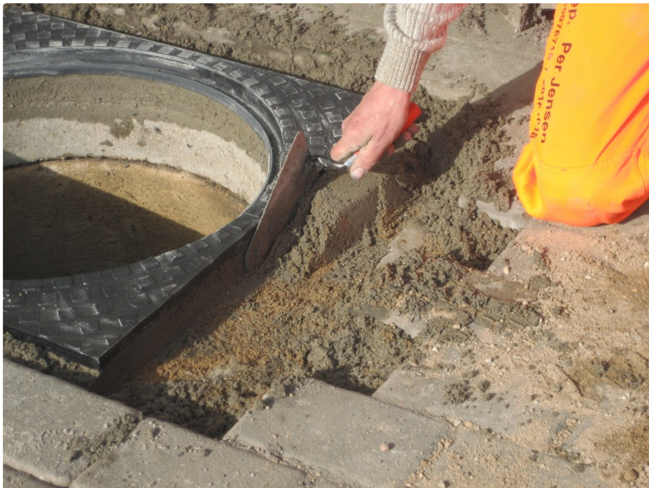
Den overskydende beton fjernes. Belægningsstenene skæres til og lægges ind til.
