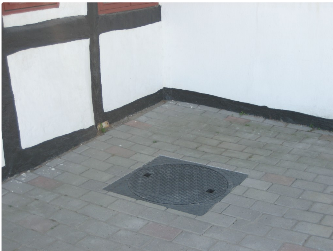
Den overskydende beton fjernes. Belægningsstenene skæres til og lægges ind til.
