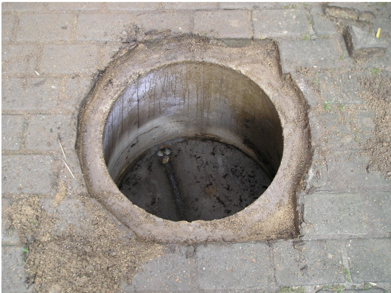
Det gamle dæksel fjernes og betonringen rengøres for jord og skidt.
