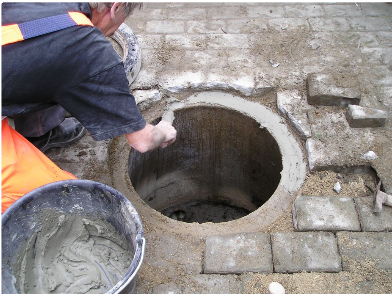
Det gamle dæksel fjernes og betonringen rengøres for jord og skidt.
