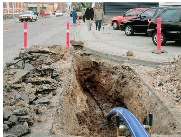
Profuse PE100 rør med ekstra aftagelig PP-beskyttelseskappe.
