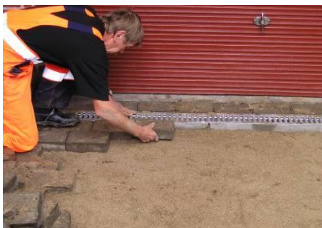
Belægningstenene lægges igen. Ristene lægges i.
