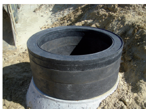
Ø600 topringe på beton kegle.
