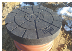
Beskyttelsesdæksel under byggeri.
