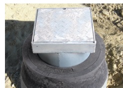
Brøndgods i kegle med indlægsring/asfaltstop.
