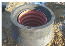
Kegle anvendt på opføringsrør.
