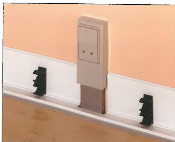
4. Panelunderlaget placeres og stikkontakten monteres.
