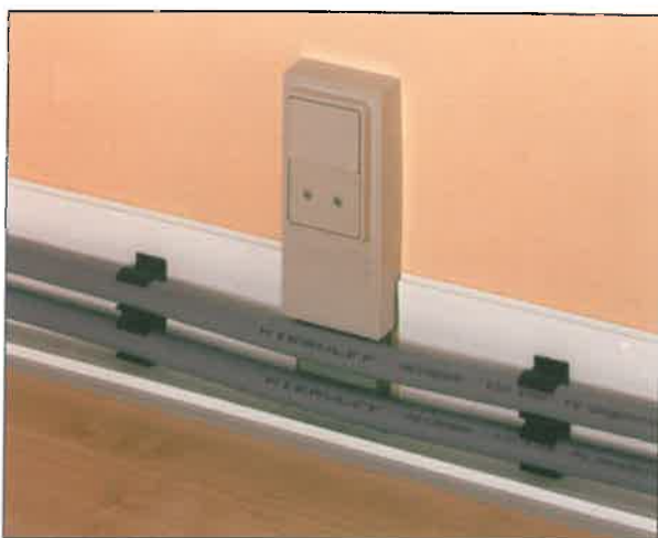
5. Rørene monteres i rørholderne.
