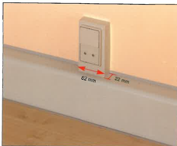
6. Der udkæres i frontpanelet, som monteres for færdig installation.
