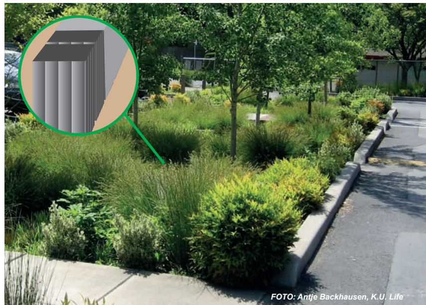
Regnbed udført som plantebed og tilsluttet BIO-BLOK® faskine.
