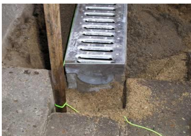
Rendeelementerne placeres efter hinanden, endevægge monteres.
