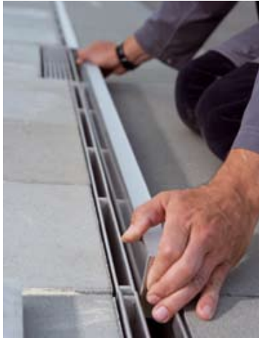
Montering af LED og kabel.
