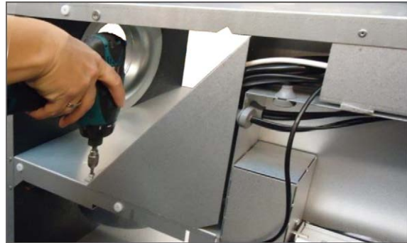
2. Kabelafskærmning demonteres (illustration 2). Skuffe med CTS 602 print, som er placeret over varmeveksleren, trækkes ud af anlægget.
