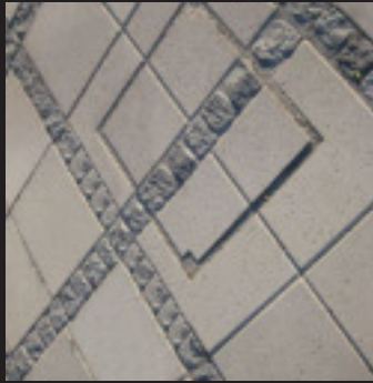
Brønddæksel over en alm. kloakbrønd i flisebelægning
