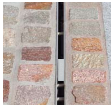
Samling ved brug af Brickslot klips
