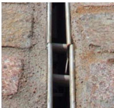
Samling uden brug af Brickslot klips.
