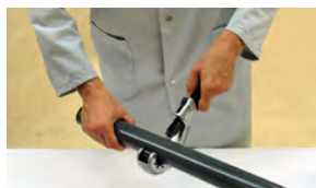
Skæring af rør
